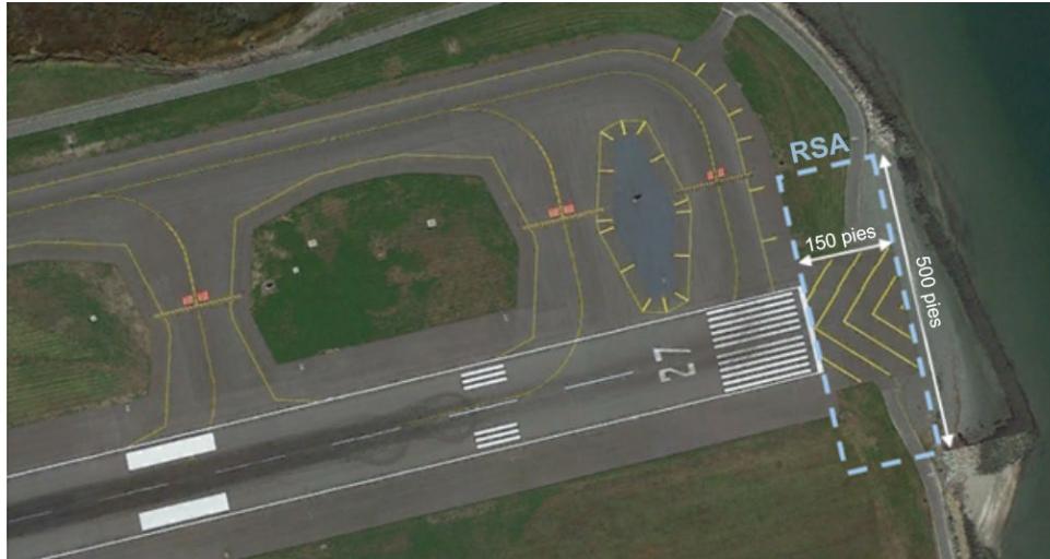
Figura RE-2 Extremo de la pista 27 - Área de seguridad actual de la pista
